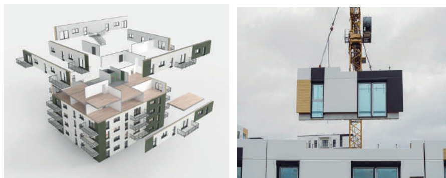
Рис 1. Сборная система компании Pekabex.
